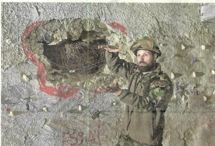
Sprengmeister Alec Rouiller zeigt das Resultat einer Probesprengung.
