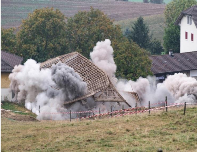
Foto: IGO/11. Oktober 2018: Sprengung alte Mühle
